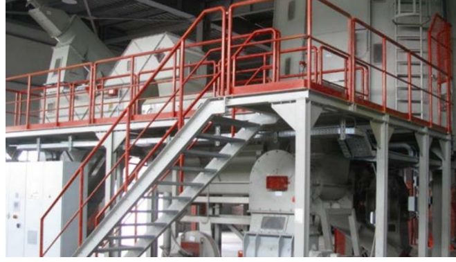
Şekil 15. Geri dönüşüm ünitesi
